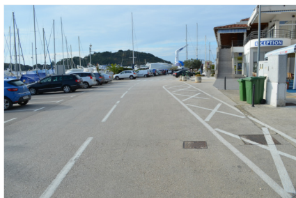
Asfaltirana zone (ceste)
